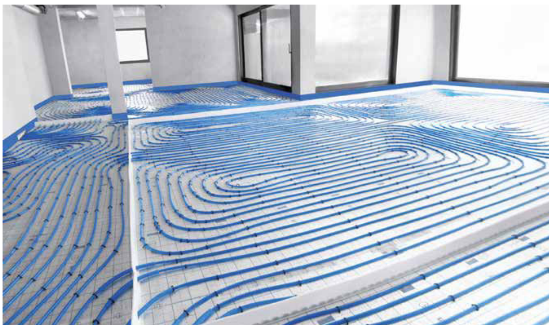
Рис. 25. Підлогове опалення/охолодження зроблене в системі KAN-therm Tacker.
