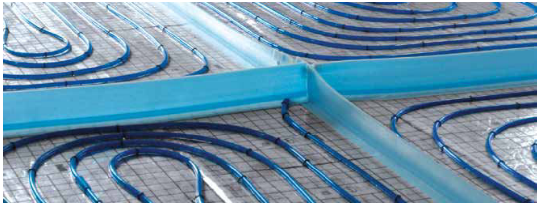
Рис. 14. Поділ гріючої поверхні демпферними швами.
