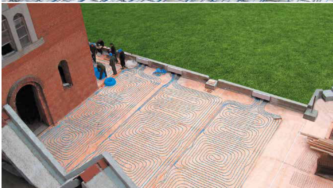
Рис. 5. Система підігріву відкритих зовнішніх поверхонь при використанні труб blueFLOOR PERT системи KAN-therm.
