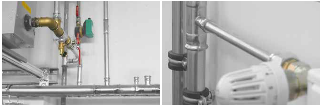
Приклади монтажу обладнання KAN-therm Steel
